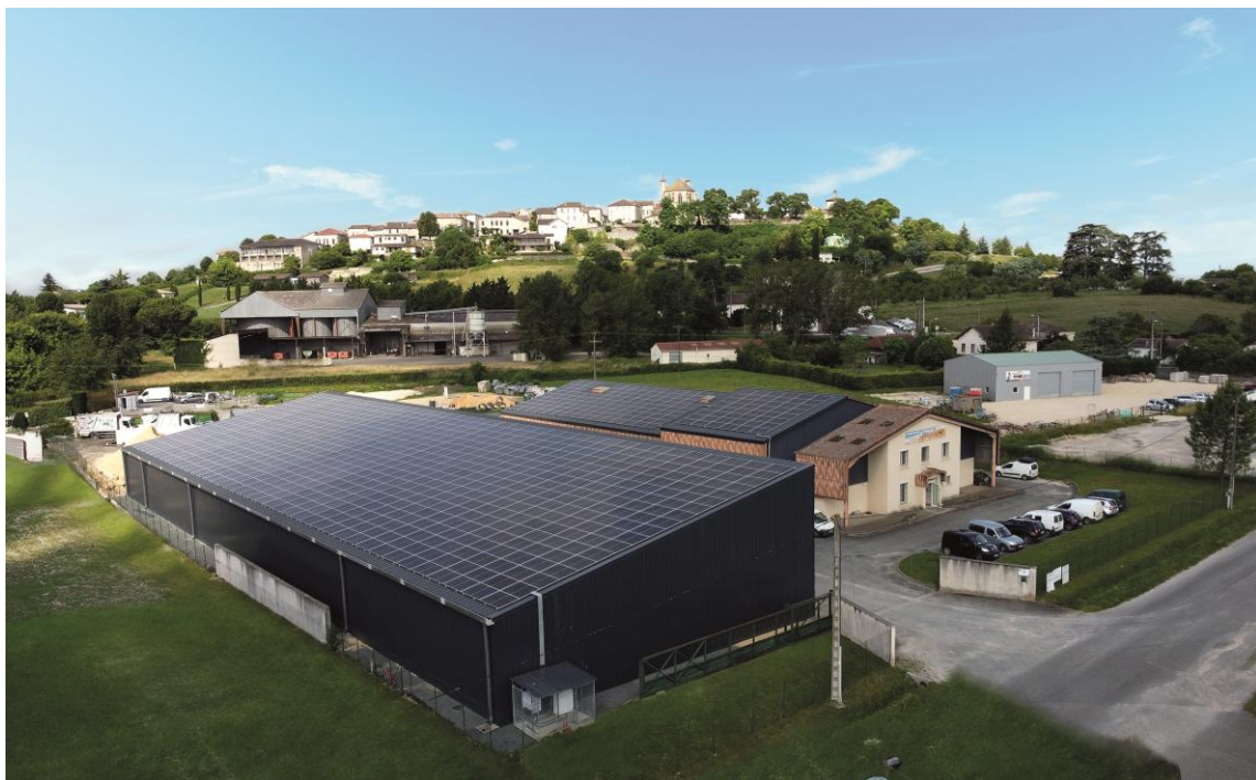
Centre technique intercommunal - Monflanquin
